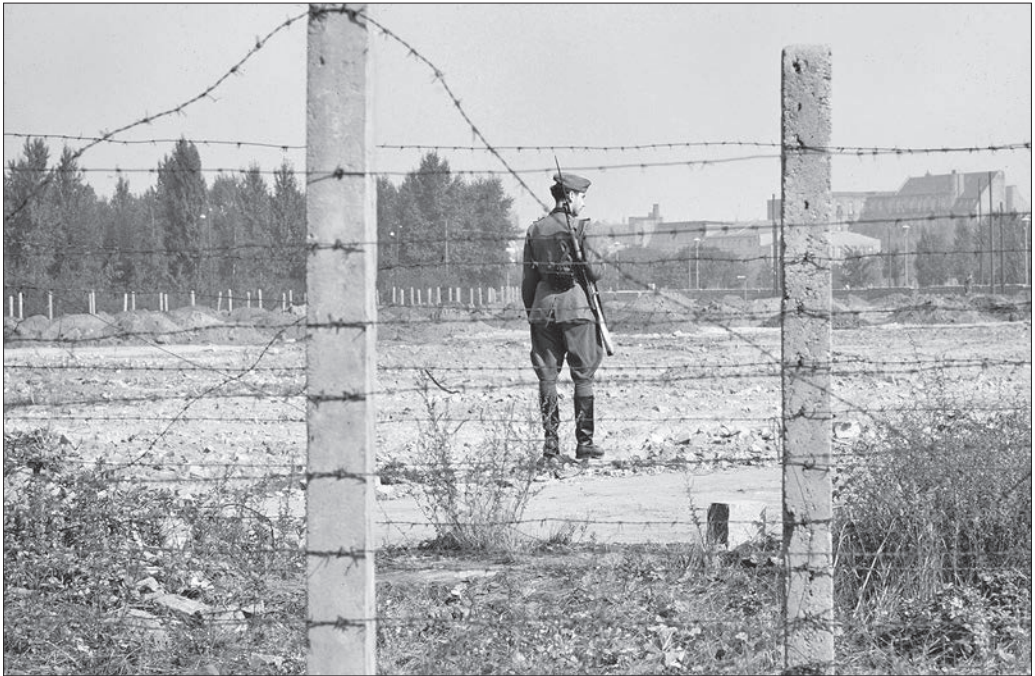
Kelet-Berlin, a felvétel a berlini fal építéskor, a Potsdamer Platz irányából északkelet felé készült. Háttérben a Behrenstraße eleje látható, 1961.
