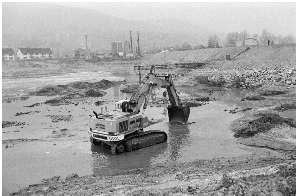
Ideiglenes Duna-meder létesítése a bős–nagygyarosi vízlépcsőrendszer építésekor, 1988 első felében
